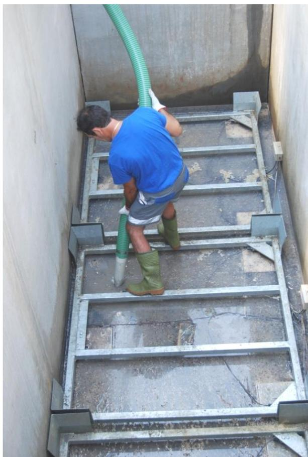
La fossa di contenimento si presenta con liquame colatticcio e residui sul fondo, che vengono aspirati da un impianto a depressione. In seguito l'operatore abilitato e equipaggiato con una lancia ad acqua ad alta temperatura e alta pressione, lava pareti e fondo della fossa, riaspirando e igienizzando.
