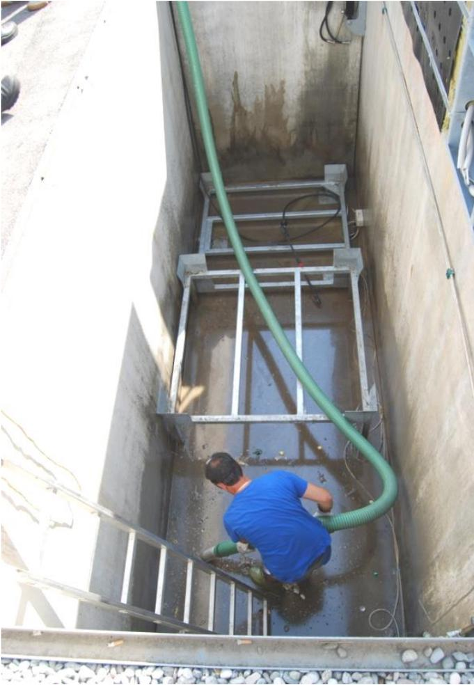
Contemporaneamente all'operazione di lavaggio, pulizia e disinfezione del contenitore, un operatore effettua pulizia, lavaggio e igienizzazione della vasca interrata, procedendo con un apposito tubo flessibile avvolgibile all'aspirazione dei detriti e liquami presenti sul fondo. Con una lancia ad alta pressione viene pulita e igienizzata.
